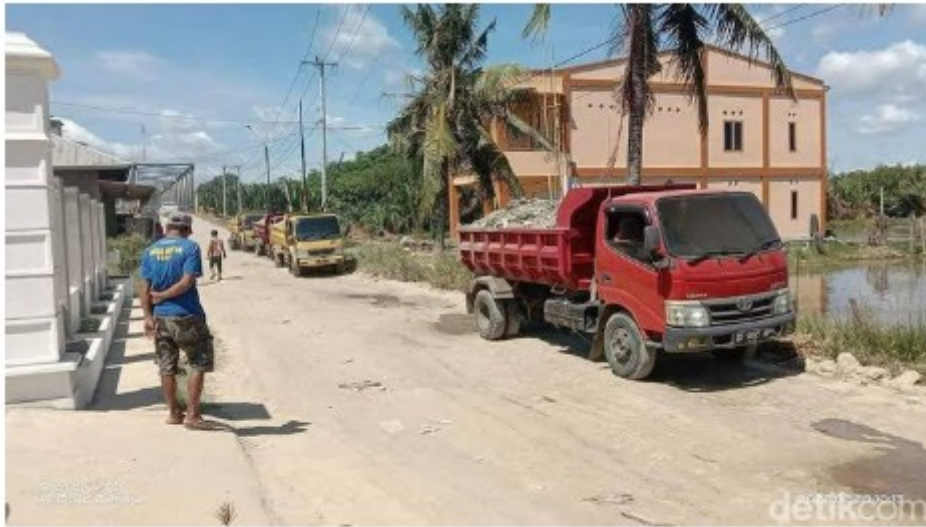
Foto: Jalan poros Kecamatan Cenrana, Bone, Sulsel yang rusak parah dan butuh perbaikan. (Agung Pramono/detikSulsel)
