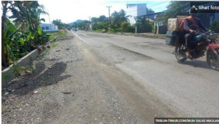
Pengerjaan Jalan Poros Makassar-Palopo di Desa Murante, Kecamatan Suli, Kabupaten Luwu, Sulawesi Selatan (Sulsel), Kamis (4/7/2024).
