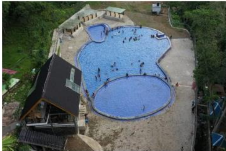
Pembangunan tahap awal Kawasan Wisata Air Panas Lejja, Soppeng yang lebih ramah anak telah rampung. (ANTARA/HD-Humas Pemprov Sulsel)
