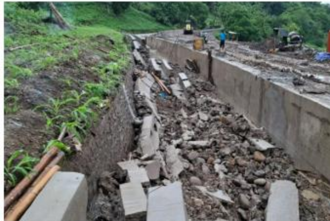
Proyek kontrol saluran induk irigasi Kelara, Karelloe ambruk. Foto: SHVO Makassar/Suleiman Hal
