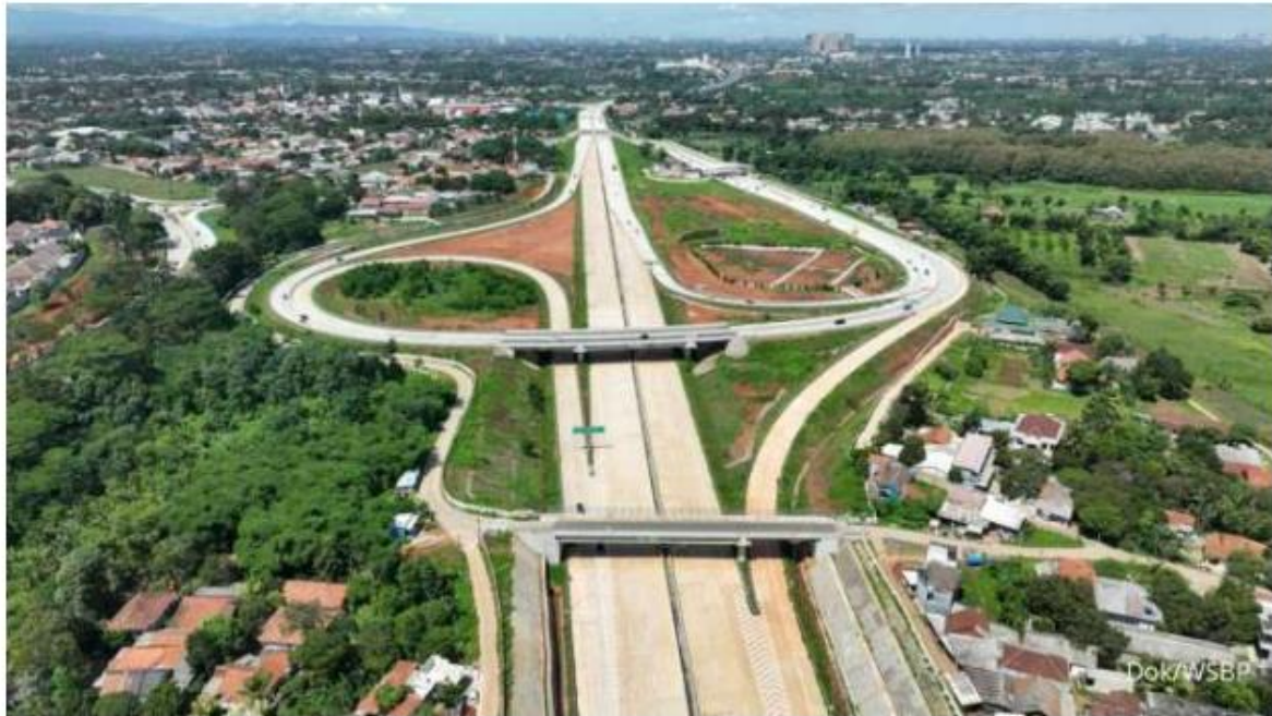
ILUSTRASI. Proyek jalan Tol Cimanggis-Cibitung (CCTW). 41 Proyek Strategis Nasional Senilai Rp 500 Triliun Ditargetkan Rampung Tahun 2024
