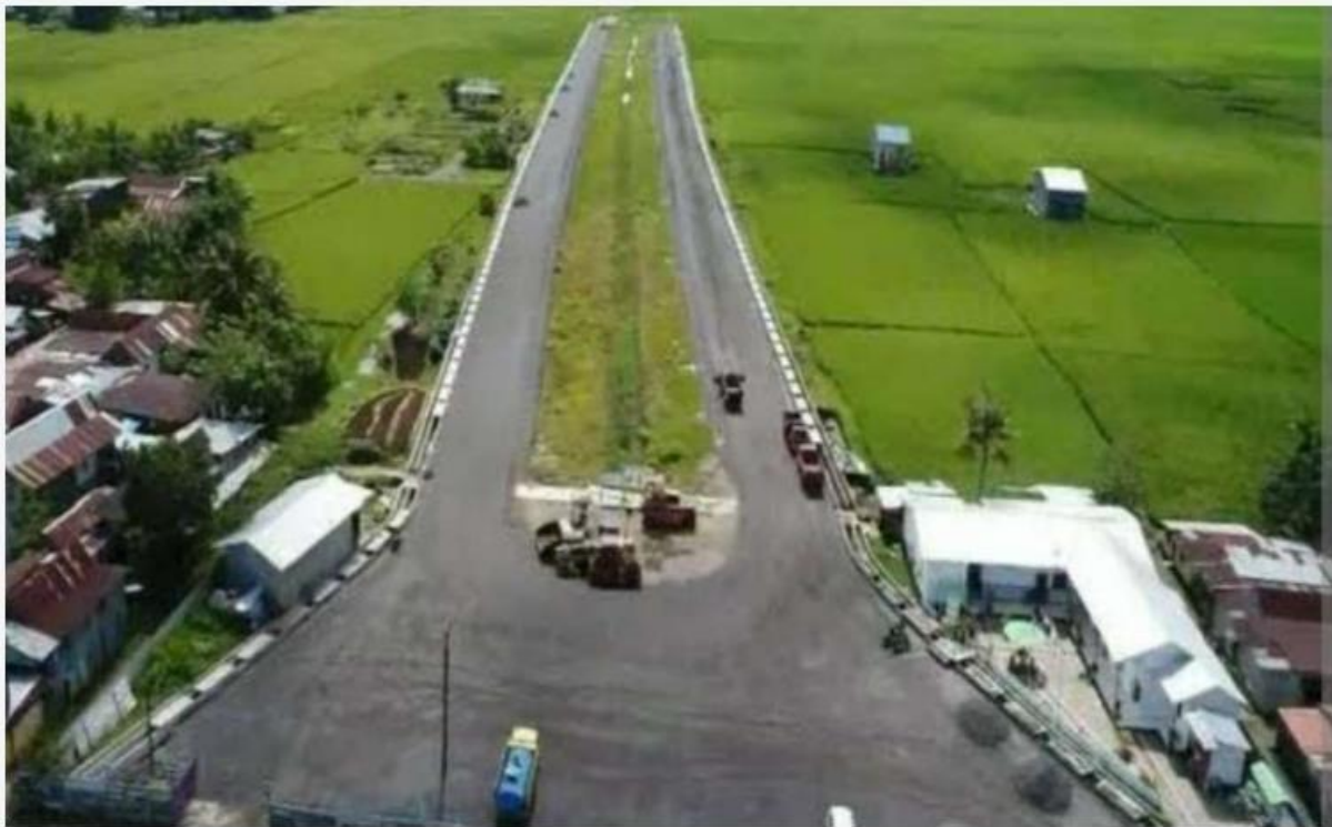
Pembangunan ruas jalan dan jembatan Maros-Makassar-Sungguminasa-Takalar (Mamminasata) Segmen I dan II (Foto: Kementerian PUPR)
