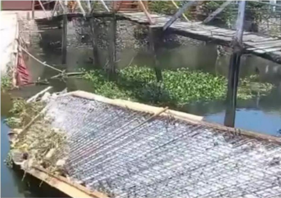
Jembatan penyeberangan di Jl Inspeksi Kanal Pampang, Kelurahan Pampang, Kecamatan Panakkukang, Kota Makassar, ambruk saat proses pengecoran, Rabu (23/10/2024). Foto: list
