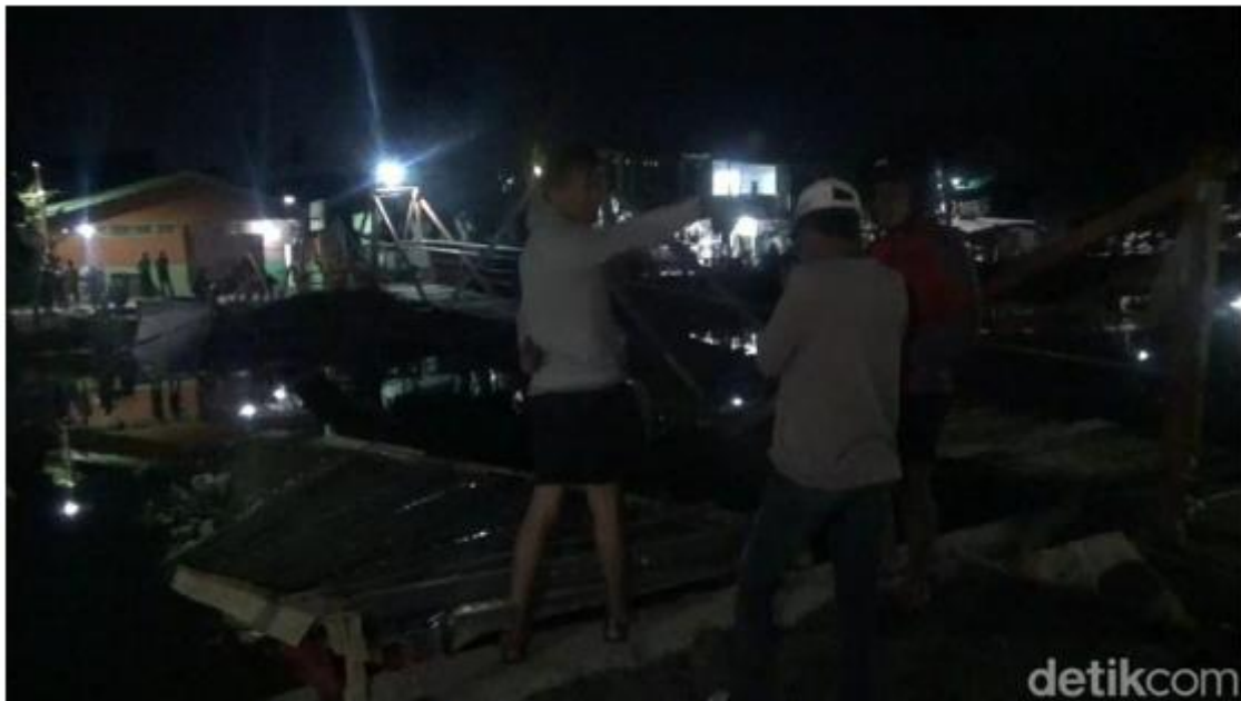
Foto: Jembatan sementara dibangun ambruk saat pengecoran di Pampang. (Reinhard Soplantila/detikSulsel)
