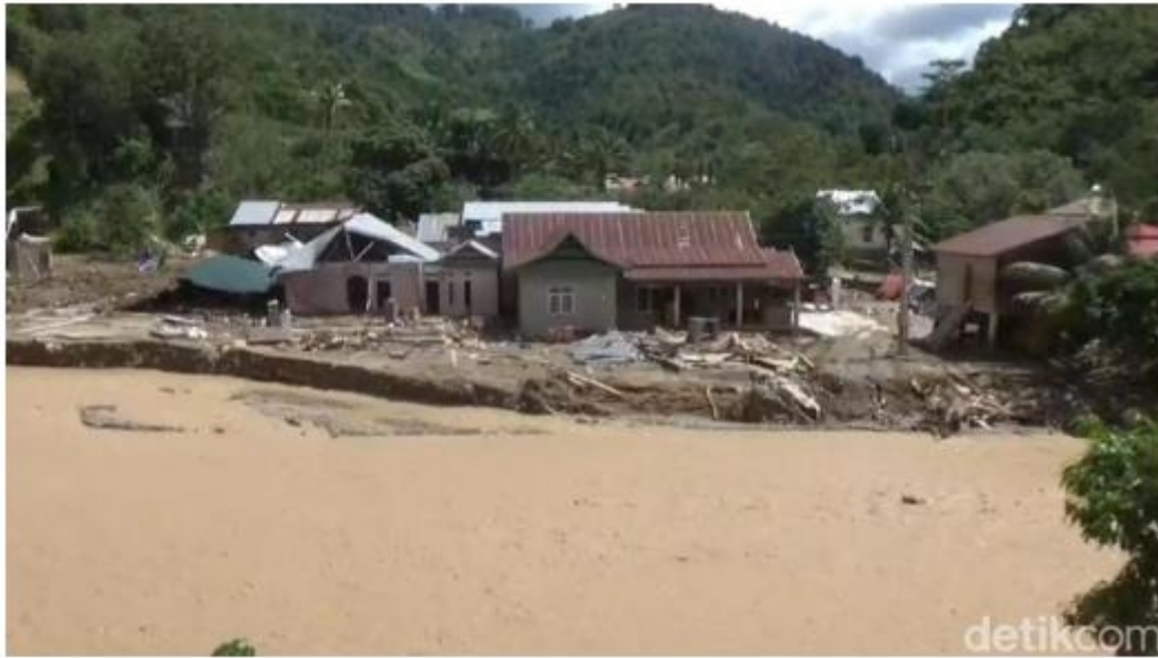
Foto: Kondisi rumah warga terdampak banjir bandang di Luwu. (Rachmat Ariadi/detikSulsel)
